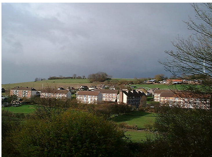
Immeubles barres : pauvreté du traitement des abords – liaison au sol et au bourg.
